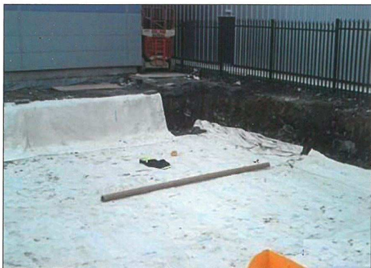
1. Wykonujemy wykop, a następnie wykładamy wykop geowłókniną
