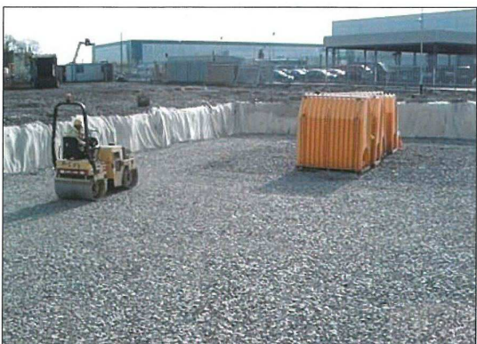
3. Tłuczeń zgęszczamy do min. 95% gęstości standardowej Proctora
