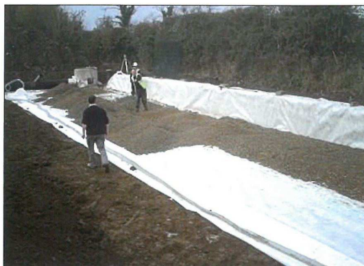
2. Na dnie umieszczamy warstwę minimum 23 cm obsypki z tłucznia (uziarnienie 20÷50 mm)
