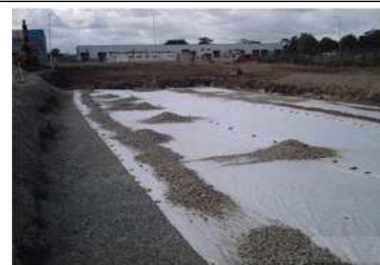
9. Układamy geowłókninę, a nad nią wykonujemy zasypkę, którą zagęszczamy co 15 cm
