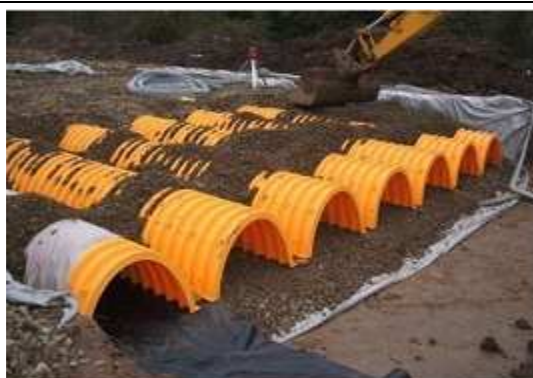
7. Przykrycie systemu wykonujemy za pomocą obsypki z tłucznia
