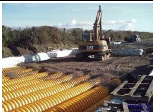
8. Warstwa tłucznia zgodna z projektem, minimum 15 cm
