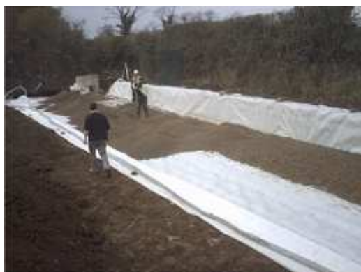
2. Na dnie umieszczamy warstwę minimum 15 cm obsypki z tłucznia (uziarnienie 31÷63 mm)
