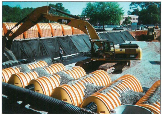
6. Przykrycie systemu wykonujemy za pomocą obsypki z tucznią
