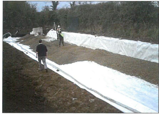
2. Na dnie umieszczamy warstwę minimum 23 cm obsypki z tucznią (uziarnienie 20÷50 mm)
