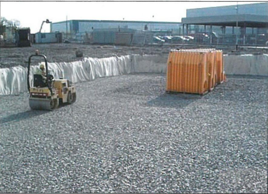
3. Tłuczeń zgęszczamy do min. 95% gęstości standardowej Proctora
