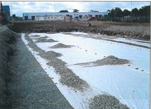
7. Układamy geowłókninę, a nad nią wykonujemy zasypkę, którą zagęszczamy co 15 cm
