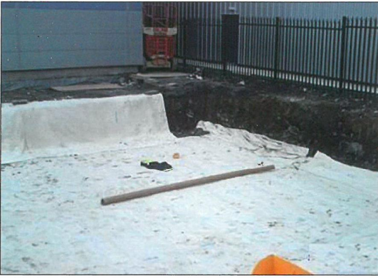
1. Wykonujemy wykop, a następnie wykładamy wykop geowłókniną
