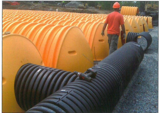
4. Układamy ciągi komór drenazowych (odstęp między rzędami minimum 15 cm)
