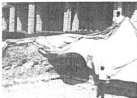
Wykonanie wykopu i przygotowanie miejsca dla łóżyska komorowego
