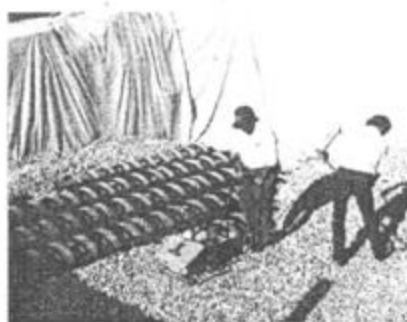
Wykonanie obsypki z tłucznia Zagęszczanie obsypki
