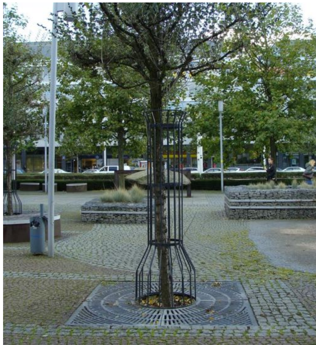
Kwadratowa krata ochronna na powierzchni pod drzewem oraz osłona pnia (fot. J. Dąbrowska)
