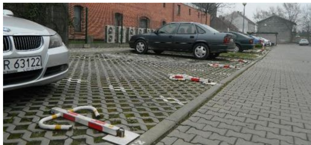
Parking z kraty ażurowej, Osiedle QUART I, Wrocław (fot. E. Burszta-Adamiak)
