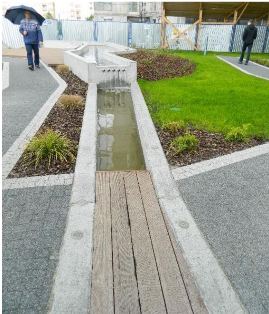
Dach zielony typu intensywnego przy ciągu pieszo-jezdnym, osiedle Arkadia II, Warszawa (fot. E. Burszta-Adamiak)
