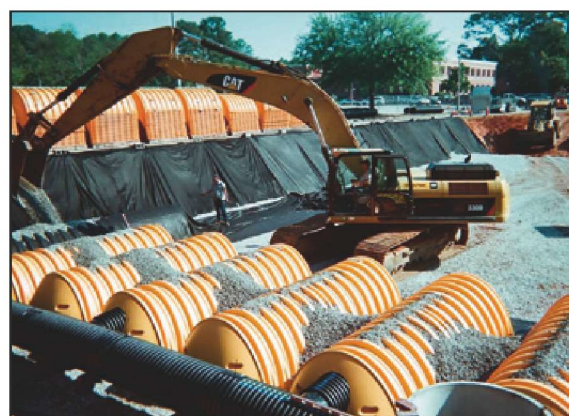
6. Przykrycie systemu wykonujemy za pomocą obsypki z tłucznia
