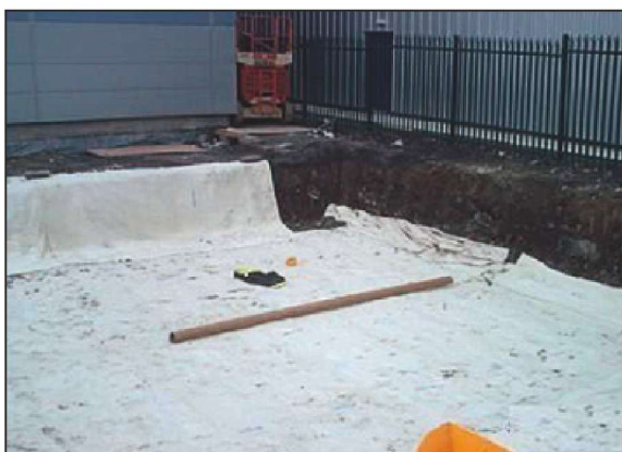
1. Wykonujemy wykop, a następnie wykładamy wykop geowłókniną
