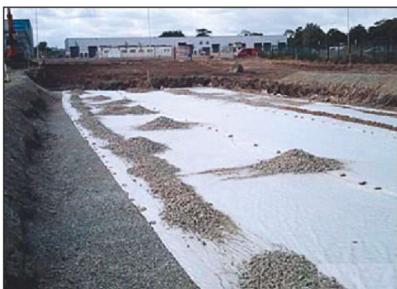
7. Układamy geowłókninę, a nad nią wykonujemy zasypkę, którą zagęszczamy co 15 cm
