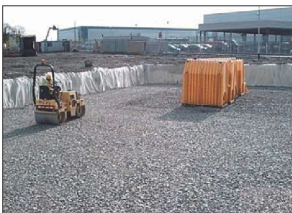
3. Tłuczeń zgęszczamy do min. 95% gęstości standardowej Proctora
